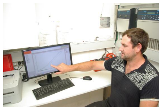
Kontrolle des Systems auf Alarme
